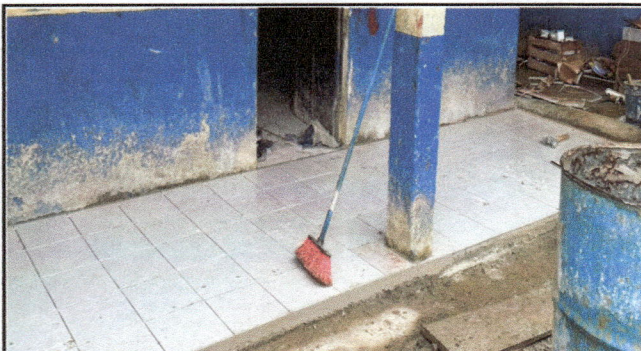
Foto 4: Se observa la sustitución de torta de cemento a piso ceramica en el corredor del establecimiento.
