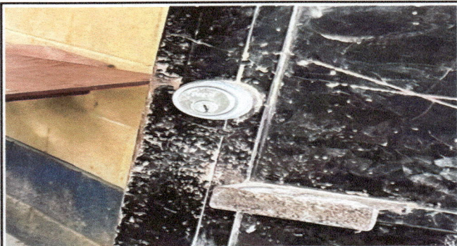
Foto 1: Se hizo la sustitución de chapa en esta puerta de metal.
