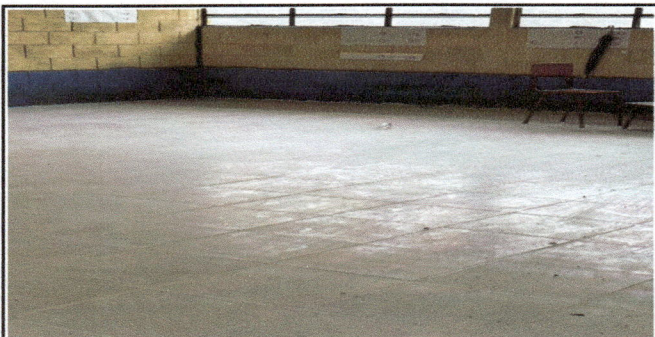
Foto 5: Se observa como quedo la sustitución de piso de torta de concreto a piso cerámico.
