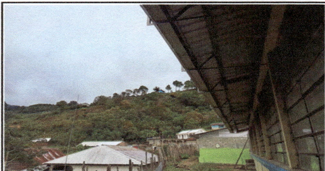
Foto 6: Se observa la sustitución de soporte o pescante de metal para canal de aguas fluviales.
